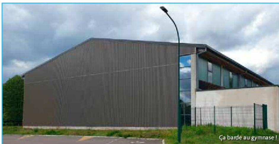
**LE BARDAGE BOIS** du gymnase (côté caserne des pompiers) vieillissait mal et des infiltrations se produisaient lors de fortes pluies. L'entreprise Damien Reynier MCT d'Amont et Effreney a effectué le remplacement des 240 m<sup>2</sup> de bardage pour un montant total de 20 776,80 €. Le choix s'est porté sur un bardage tôle en raison de la pérennité du produit et de sa très bonne étanchéité. Par ailleurs les crochets brise neige ont également été revisités et étanchéifiés.
