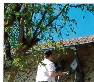
***L'antenne, carré de 40cm x 40 cm se fixe en façade, sur cheminée ou sur tige d'antenne râteau ... Un câble très fin, (RJ 45 type câble informatique) relie l'antenne et la box.***
