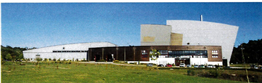
L'usine de traitement et d'incinération du SYTEVOM à Noidans le Ferroux
